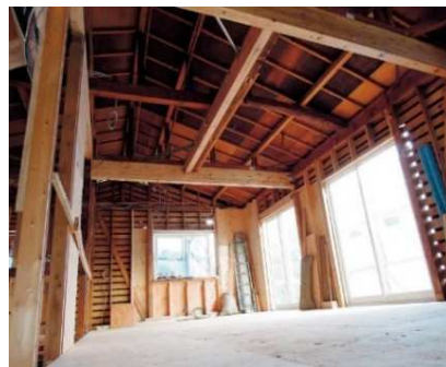
施工中(構造躯体まで解体した状態)
