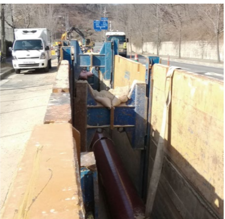
図2. 蔚山工業団地の蒸気配管工事の様子
