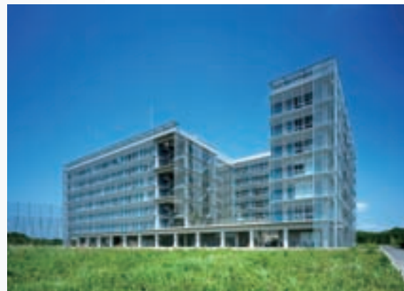
柏キャンパス環境棟 (株)川澄建築写真事務所
