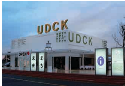
UDCK外観(屋外の広場・木製デッキにはイスやテーブルもある)
