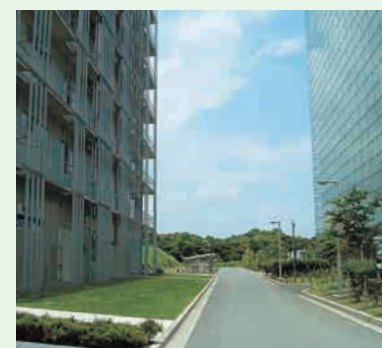
生命棟と環境棟の間の新名所「風の谷」
