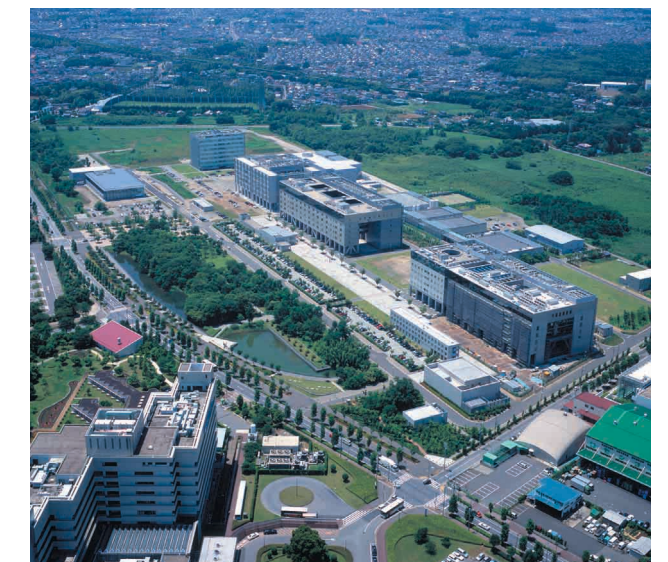
研究棟の建設が進む東大柏キャンパス
