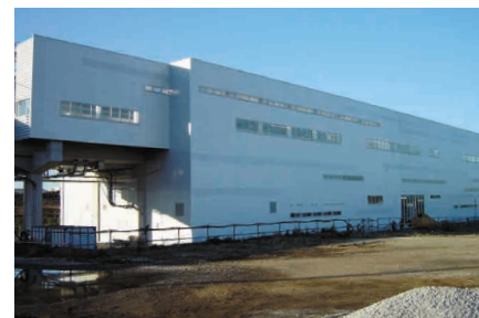
完成間際の駅舎の外観
