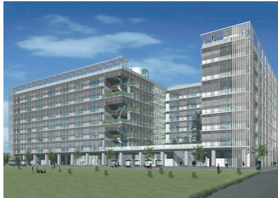
環境棟の完成予想図：環境負荷低減を目標に設計され、ルーバーの組み合わせが外観の意匠にもアピールしている。空間構成にも学融合の概念を展開し、交流の場の工夫が盛り込まれている。
