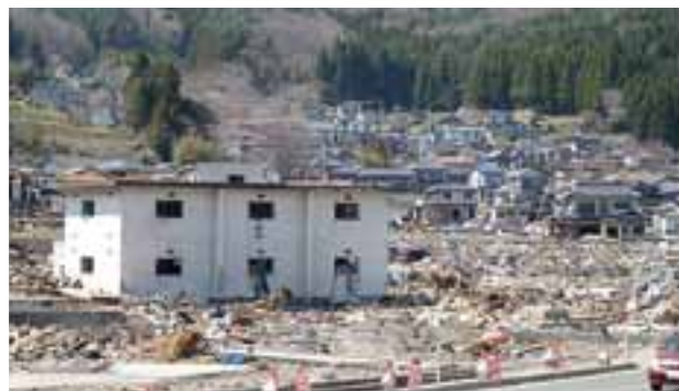
木造家屋は浸水深が約2mで流失します。手前の低地では浸水深が大きかったので、木造家屋はすべて流失し、残ったのは鉄筋コンクリート造りの家などです。奥側の斜面では地盤高が高いので、家屋が無事に残っています。岩手県大槌町浪板海岸
