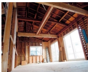
施工中(構造躯体まで解体した状態)
