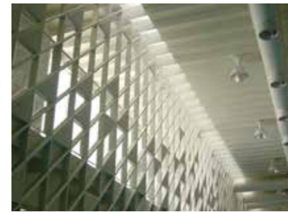
図2：スチールフラットバーで構成されたメッシュ状の構造(はこだて未来大学研究棟, 2005年)
