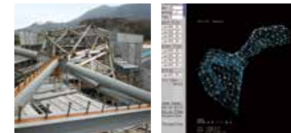
図3：多面体の構造の下部となる鉄骨(下関市川棚温泉交流センター, 2010年)
