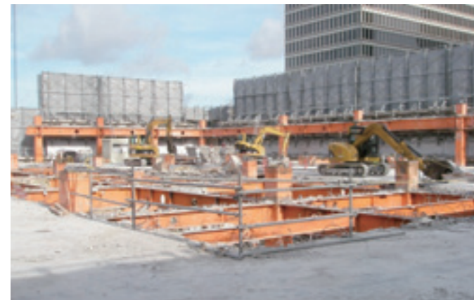
超高層オフィスビルの解体現場
