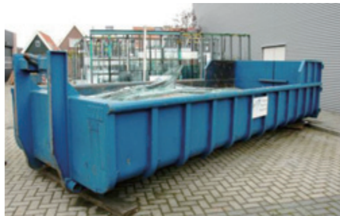
オランダの解体現場でのガラスの回収ボックス
