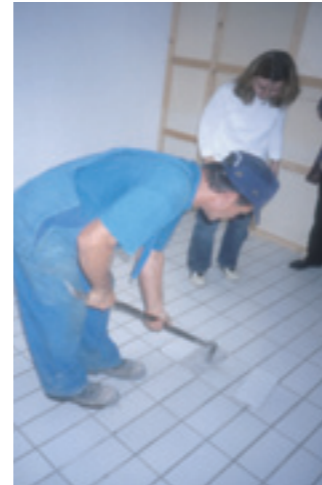
ミュンヘンの解体現場で事前調査のために床のサンプルを採取する様子
