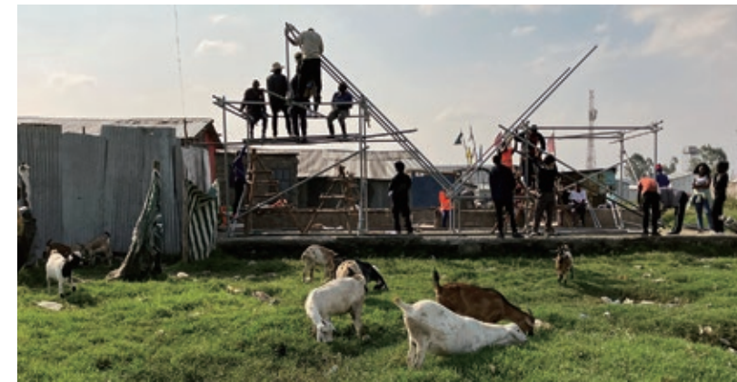
▲強制撤去が行われた後、住民と共に実施した屋根の自力建設作業の様子。 ▶東日本大震災後に自力建設された漁業用小屋の実測図。
