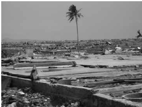
東日本大震災の7年前の2004年、インドネシアのバンダアチェはインド洋で発生したM9の地震による大津波で深刻な被害を受けている。この経験は活かされたのだろうか（写真：海岸部では津波でほとんどの家屋が流された）
