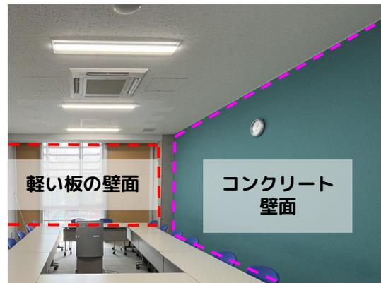
荷重柱とフロアの床を除いて、残りの壁面は軽い板を使用しています。これにより地震が発生して壁面が倒壊する時に、被害を最小限に抑えることが期待できます。板材だけの使用では安定性が不足しますが、外壁の鉄骨構造と組み合わせているので、安定性が高いと考えられます。防音効果についてはコンクリート壁に劣りますが、環境棟では、大きな騒音を立てることは多くなく、現在のところ特に問題はないようです。
