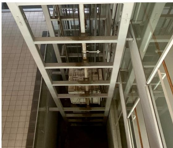
環境棟のエレベーターホールに、建物全体を貫通する「クールチューブ」が設置されています。クールチューブは、地中に埋設した管を通して地上と地下の温度差による圧力差で換気を促進する手法です。夏は涼しい空気を、冬は暖かい空気を送ることができます。特に夏の場合には、エアコンを使わなくても廊下や中庭にある熱の空気が自然に上昇し、配管を通じて排出され、温度を自動的に下げる調整効果があります。
