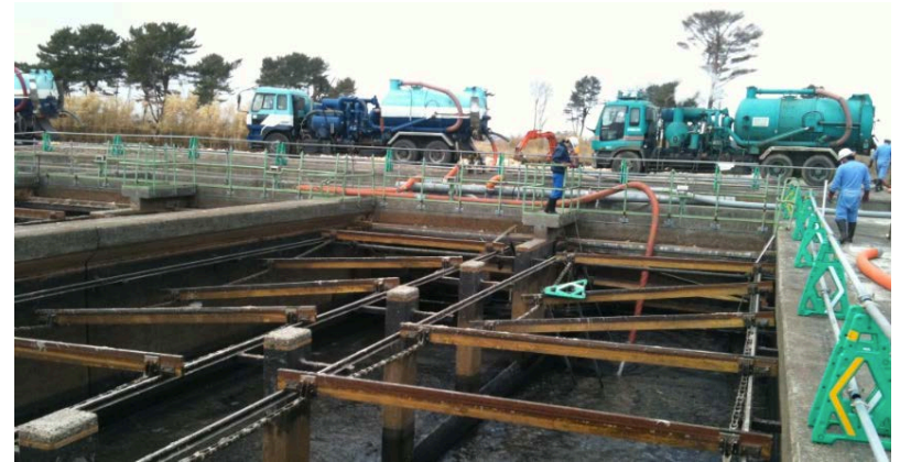
津波被災した下水処理場の復旧工事
